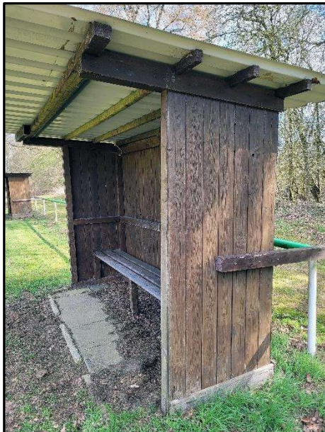
Trainerbank vor Umbau
